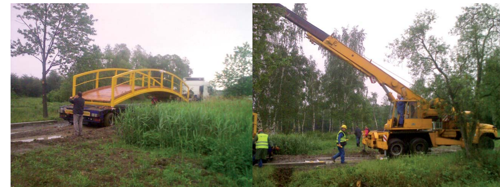
Stavba můstku přes potok Bouřlivec, jamka č. 7
